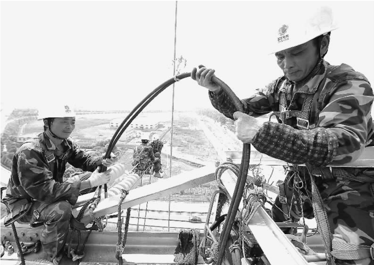
7 月 6 日, 武汉光谷变至乙烯变 220 千伏线路最难点提前 4 天完工, 为武汉 80 万吨乙烯工程投产提供了可靠电源条件。图为湖北省送变电工程施工人员在 60 米高塔上架线施工。 邹小民摄
